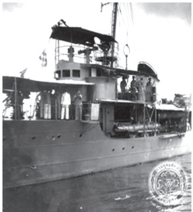
■ ภาพเรือหลวงสุราษฎร์ จะมองเห็นตอร์ปิโดที่อยู่ด้านข้างสะพานเดินเรือฝั่งกราบซ้ายได้ชัดเจน
